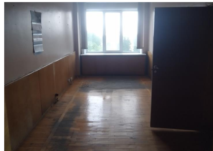
Демонтаж настенных деревянных элементов
