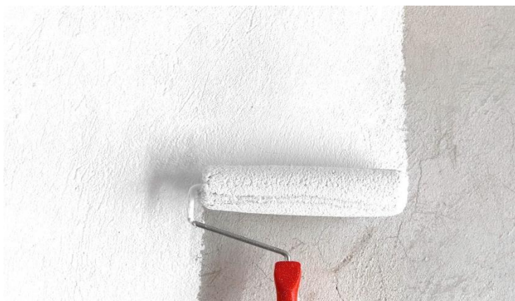
Покраска стен (нанесение декоративной штукатурки) в светлых тонах
